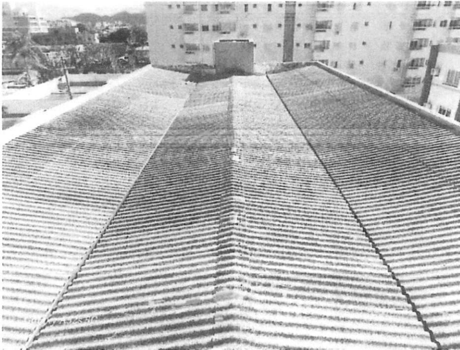
Figura 5 – Foto panorâmica do telhado da câmara Municipal de Bertiooga
