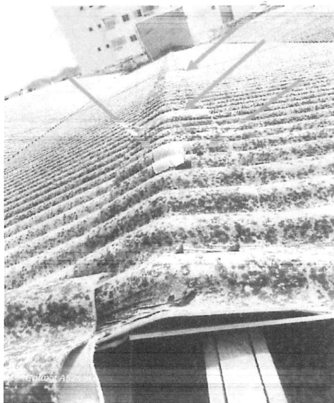
Figura 6 Parafusos oxidados e remendos aparentes
